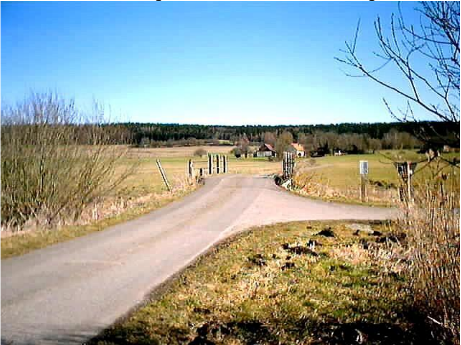
Brücke über die Ostrach mit Laubbacher Mühle, beim Dreiländereck Laubbach
