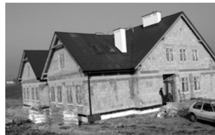
Teren budowy „Farmy życia”
